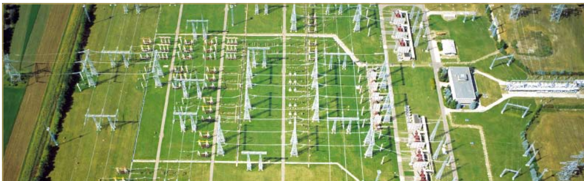
A 750/400 kV-os Albertirsai állomás 750 kV-os kapcsolóberendezésének részlete
