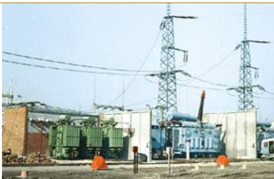
A Gödi alállomás 400 kV-os transzformátora és söntfőjtője
