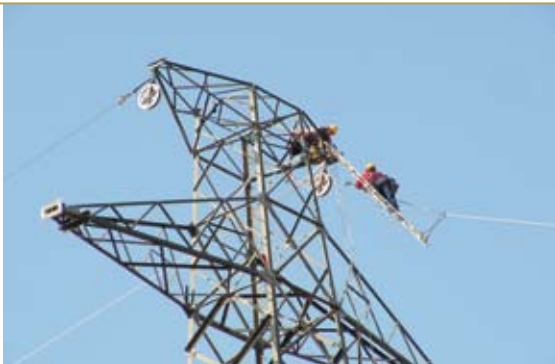
A Békéscsaba–Országhatár–(Nadab)–Arad távvezeték építése
