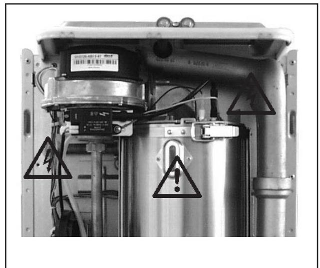
Bild: Zündtrafo, Hochspannungs-Zünder, Brennkammer
